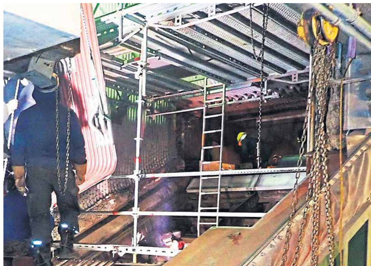
Wo sonst der Müll brennt, wird während der Revision fieberhaft an der Wiederherstellung des Kessels gearbeitet
