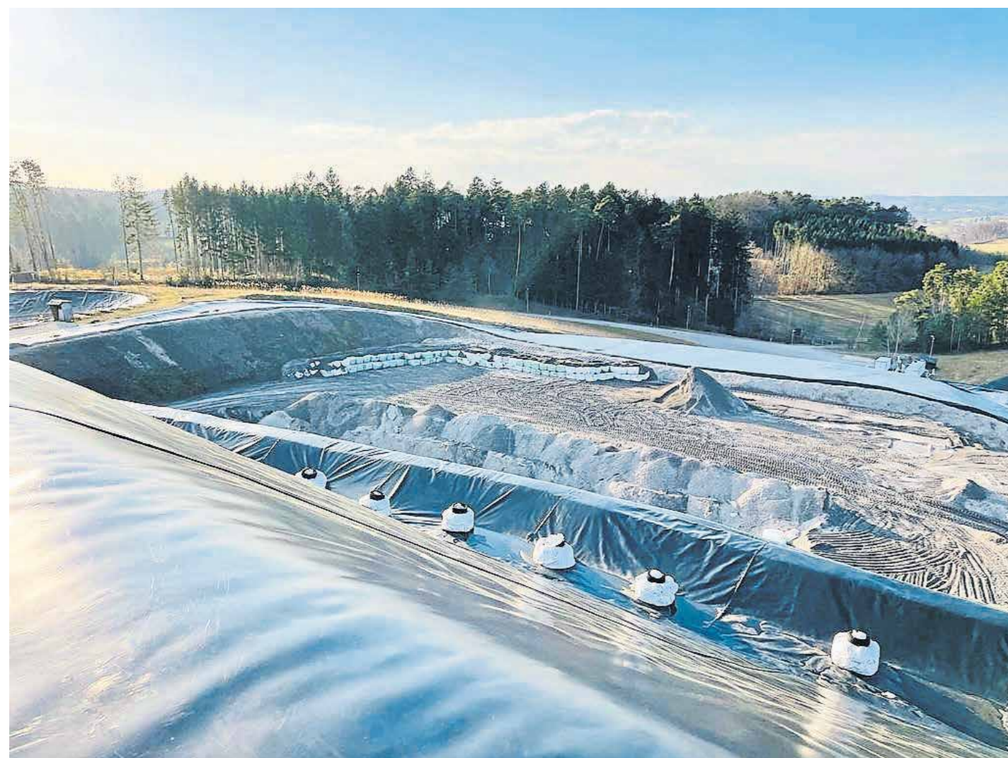
Die Deponie Eberstetten, eine nach höchsten Ansprüchen angelegte Reststoffdeponie für die gesicherte Entsorgung von Asbest.
