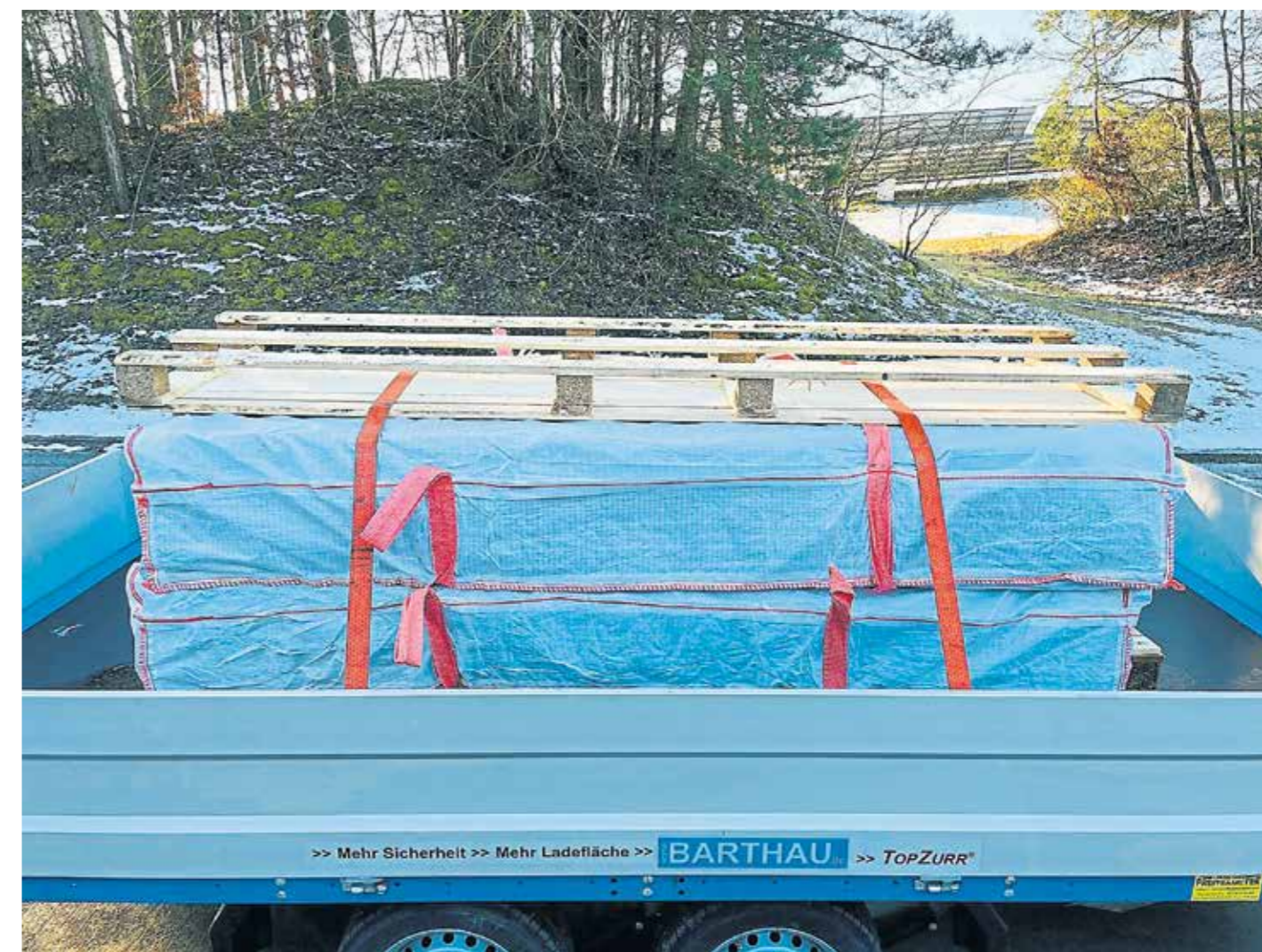
Asbest richtig angeliefert auf der Deponie – geschlossen und verpackt in BigBags mit den Schlaufen nach oben.
