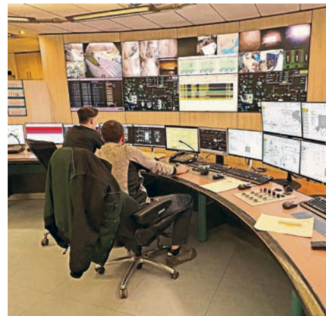
Das Gehirn der MVA Ingolstadt – die Messwerte
