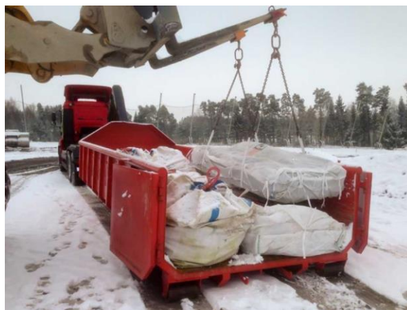
Big-Bag's mit Schlaufen (ganze Dachplatten)
