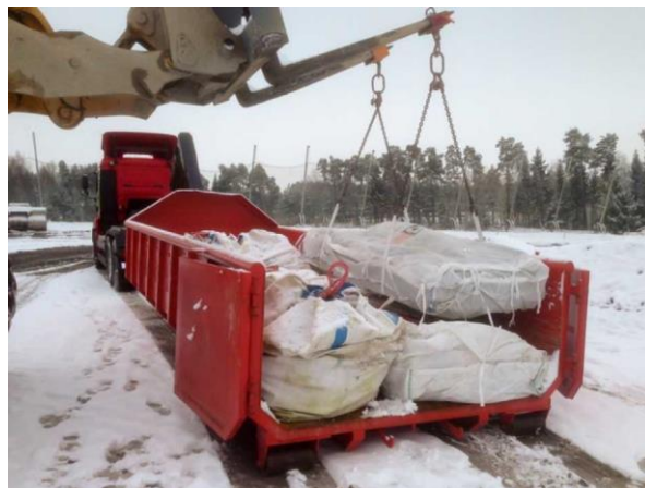
Big-Bag's mit Schlaufen (ganze Dachplatten)
