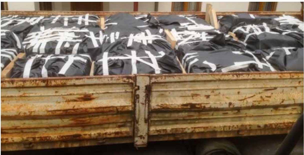
Große verpackte asbesthaltige Bauteile, mit Kanthölzern verkeilt gegen Ladungsverschiebung
