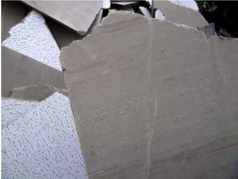
Demontierte Deckenverkleidung aus Mineralfaserverbundplatten
