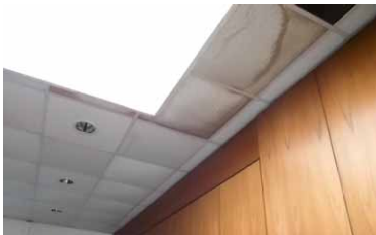
Eine typische Deckenverkleidung aus Mineralfaserverbundplatten die erneuert werden soll
