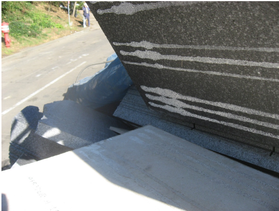
Ein Wärmedämmverbundsystem mit Polymer FR-haltigem Dämmstoff (vom Hersteller nachgewiesen)
