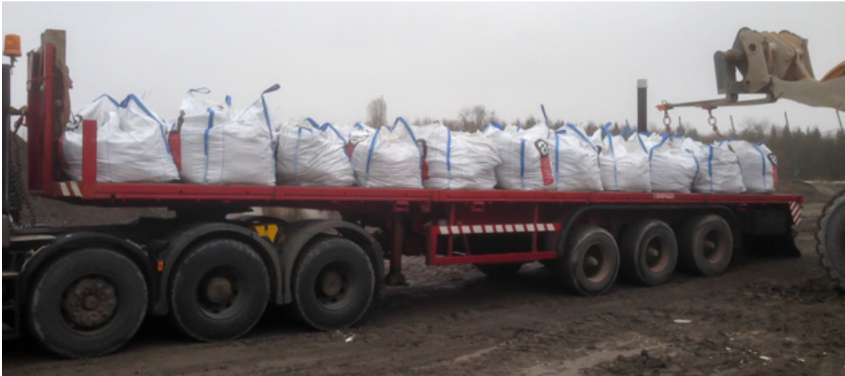
Asbesthaltige Baustoffe in Big Bags, Entladung auf der Deponie Eberstetten mit dem Radlader und der montierten Ladegabel
