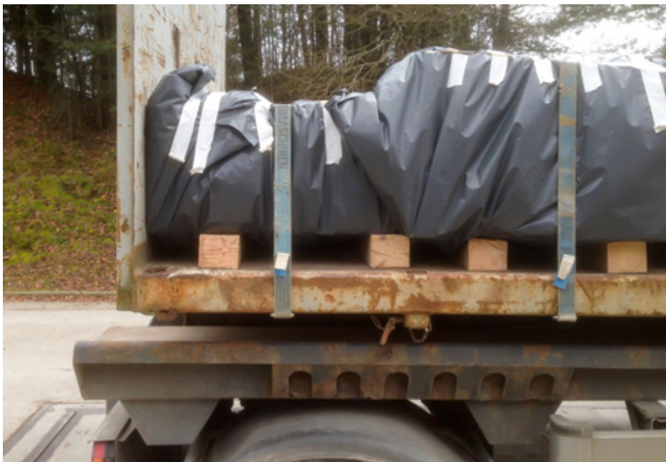
Großes verpacktes asbesthaltiges Bauteil auf Kanthölzern mit Ladungssicherung
